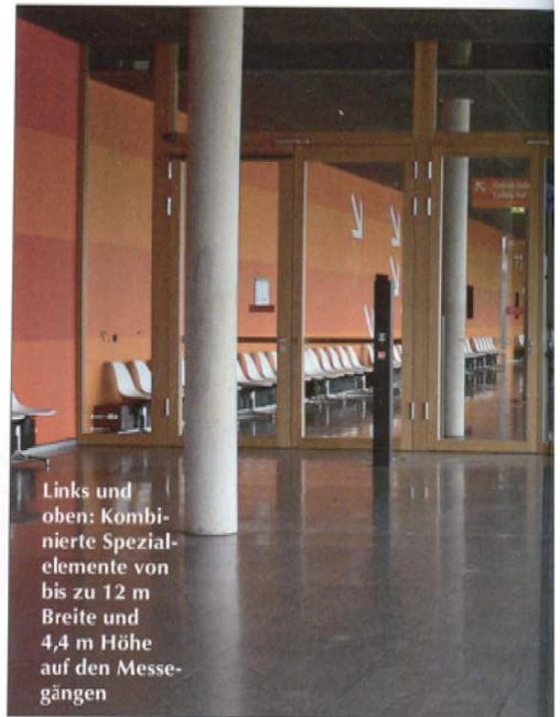
Links und oben: Kombinierte Spezialelemente von bis zu 12 m Breite und 4,4 m Höhe auf den Messegängen
