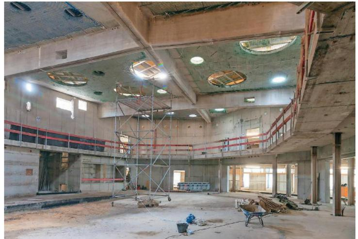
Die Dachkonstruktion des Plenarsaals wurde komplett erneuert, gedämmt und mit kreisrunden Öffnungen versehen. FOTO: THOMAS
